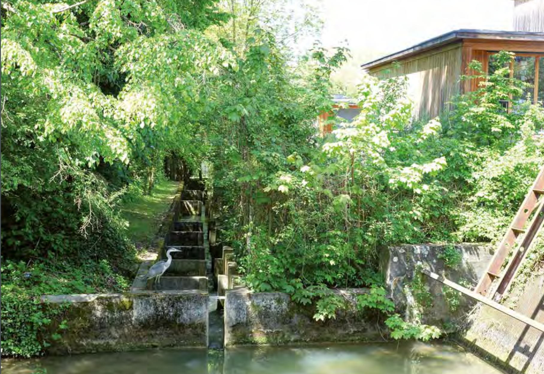
Beim Einlaufbauwerk (rechts) endet heute der alte Schappekanal. Der frühere Überlaufkanal (links) ist zur Fischtreppe ausgebaut worden.
