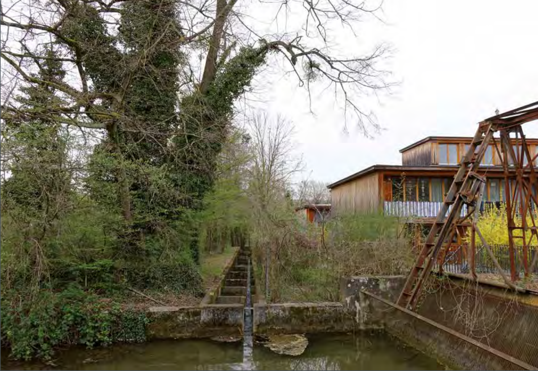
Der früher zur hydraulischen Energiegewinnung genutzte Schappe-Gewerbekanal dient heute als Umgehungsgewässer mit Fischtreppe.
